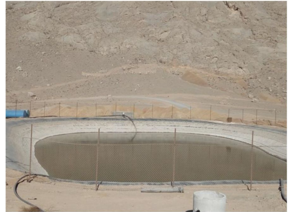
اجرای مخازن ذخیره و بازگشت آب
