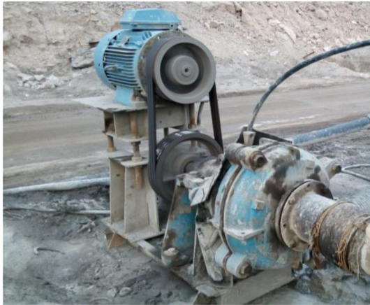
اجرای سیستم‌های پایپینگ و طراحی و تأمین پمپ‌های آب و دوغاب
